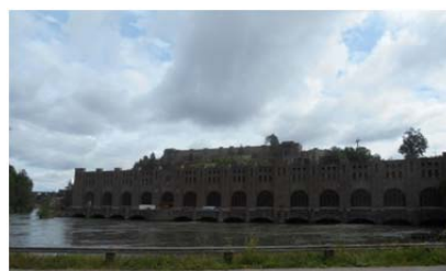
Bild 22. Olidans kraftstation. Foto Göran Hjort
